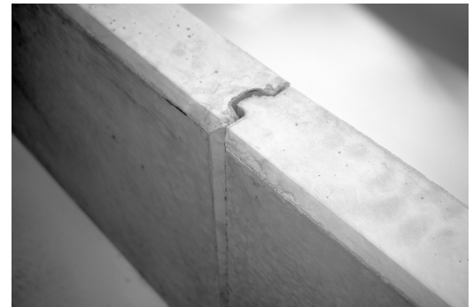
Lakka L-tukimuurin ponttiliitos
