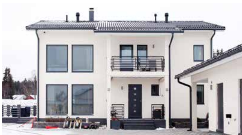
Kodin energiatehokkuus varmistettiin Lakka-eristeharkoilla.
