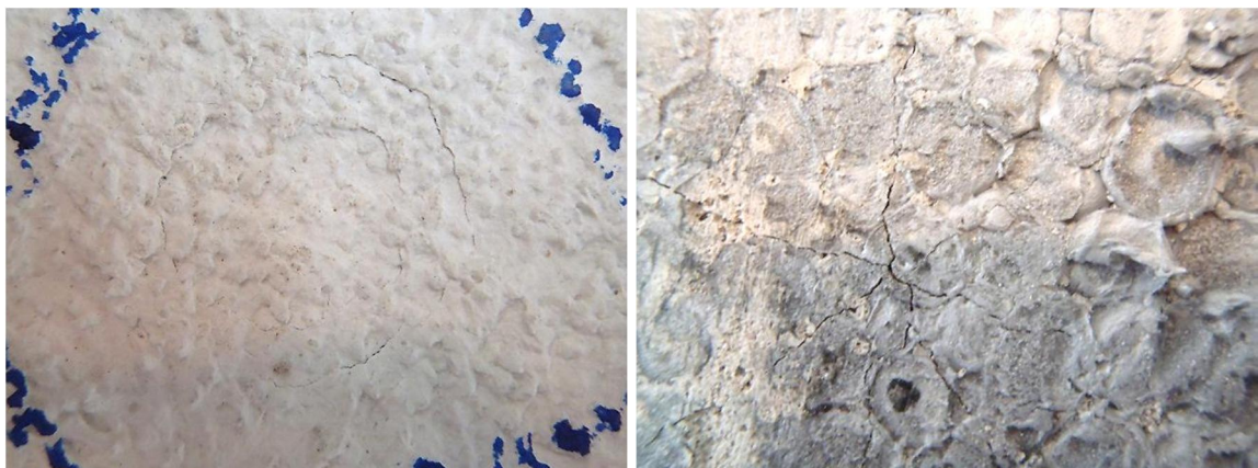
Kuva 5.3. 10 joulun iskukokeessa syntynyt rappauksen läpäisevä halkeama.
