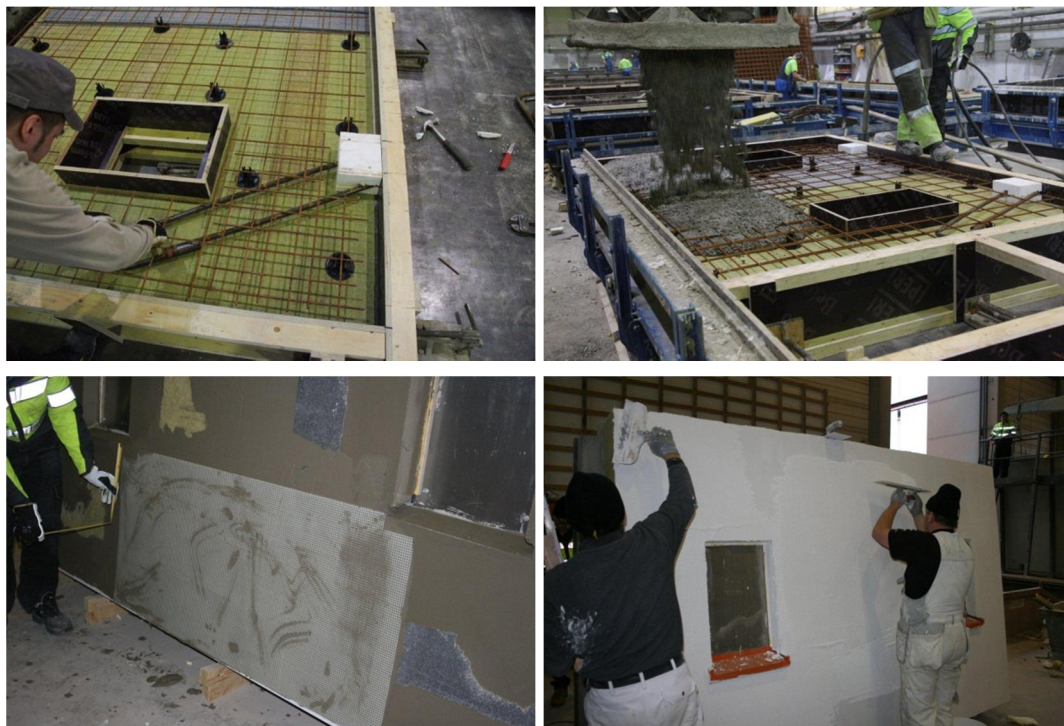
Kuva 2.1. Koeseinän valmistuskuvauksia Lakan Betonin elementtitehtaalla.
